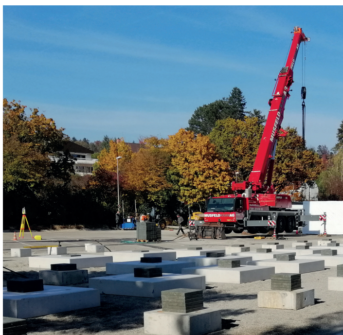
Betonfundamente sichern einen guten Stand der Container für das Provisorium Schulhaus „Surmatten“.
