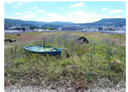
extensive Dachbegrünung des Parkhaus Kägen
