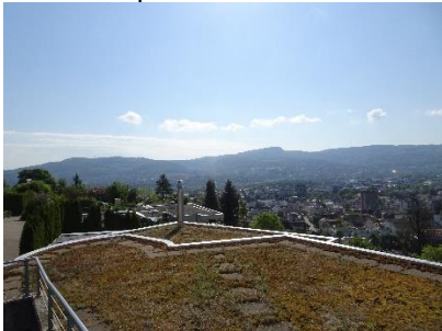
Extensive Dachbegrünungen sind im Zonenreglement verankert.
