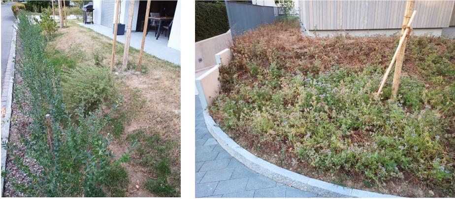
*In Hitzeperioden sind 50 cm Deckschicht knapp: Anhand der dünnen Vegetation ist deutlich erkennbar, wo sich unter dem Boden die Einstellhalle befinden.*
