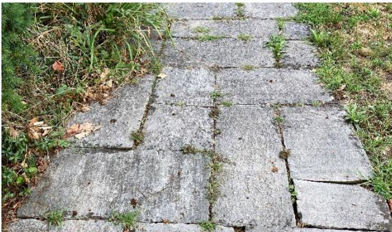
*Bodenplatten mit offenen Fugen z.B. für häufig
